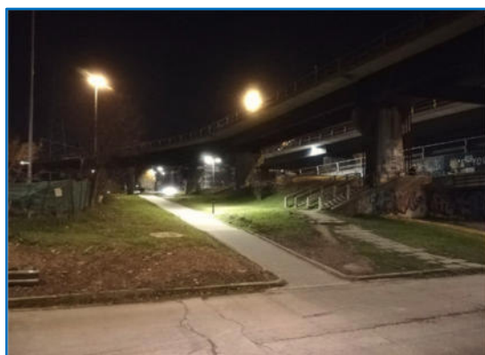
Via Lunga – Q. 4 nuovo impianto di illuminazione
